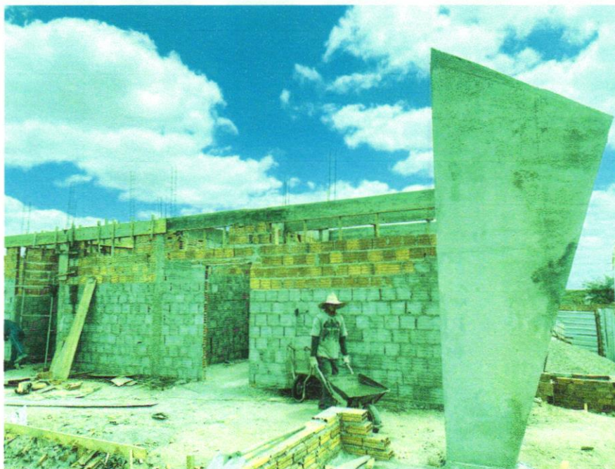
IMAGEM 02 - MONTAGEM E DESMONTAGEM DE FÔRMA DE VIGA, ESCORAMENTO COM PONTALETE DE MADEIRA, PÉ-DIREITO SIMPLES, EM MADEIRA SERRADA, 4 UTILIZAÇÕES. AF_09/2020
